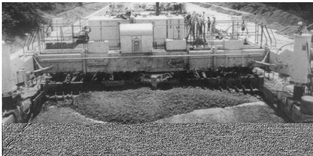
CMI SF6004 摊铺水泥路面施工图
