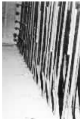
图 2 新增剪力墙植筋
