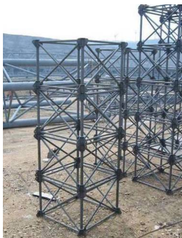
图 2.2-1 钢结构组合式临时支撑架
