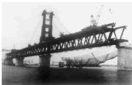
图 9 采用吊索架全伸臂安装 144 m 钢梁
