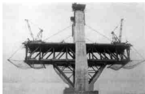
图 10 双伸臂安装 312 m 主孔
